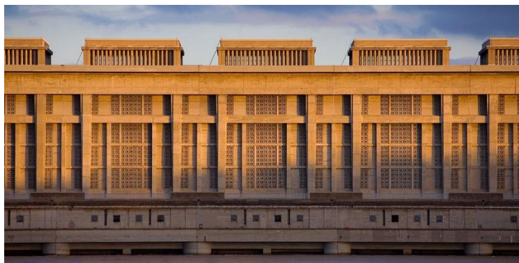
La façade (classée MH) de l'usine Blondel
