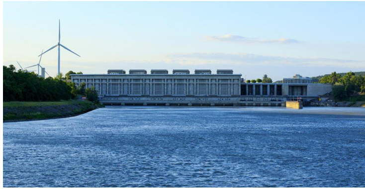
L'usine Blondel et l'écluse de Bollène (à droite)
